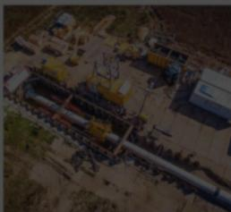
Der Vorschub der vorgefertigten Pipeline vom Startschacht erfolgte mit einem Pipe Thruster HKS00PT von Herrenknecht.
